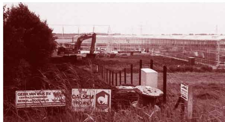
Ook hier bouwt Gebr. Van Wijk
