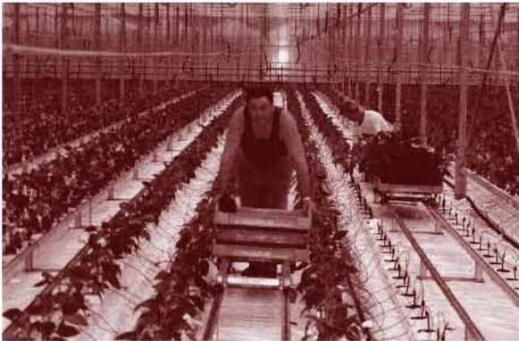
Buisrailverwarming: de verwarmingsbuizen doen tevens dienst als rails voor de karren van de tuinder. Eenvoudig als doeltreffend.
