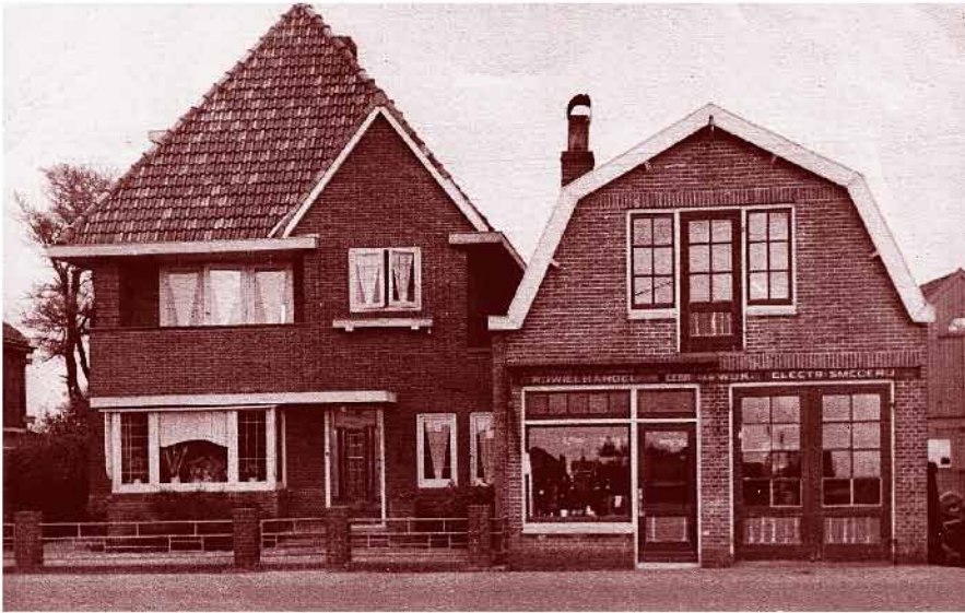
Rechts de nieuwe smederij (1926), links het nieuwe woonhuis (1933), beiden gebouwd in opdracht van Jan van Wijk (1891-1972)
